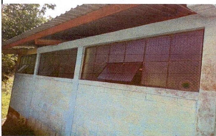
Foto 3: #2. Mejoramiento de Ventanales.
