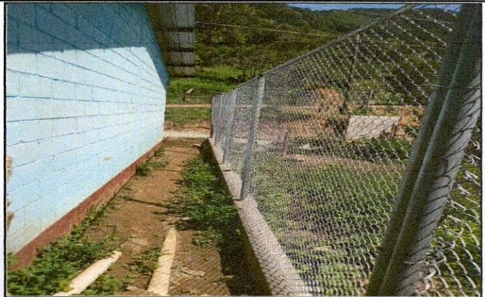
Foto 2: #1. Mejoramiento de Cerco o muro perimetral.
