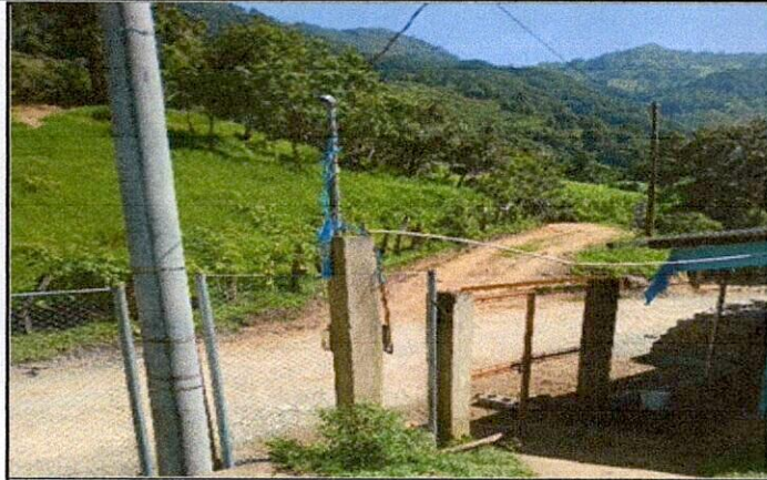
Foto 1: #1. Mejoramiento de Cerco o muro perimetral.
