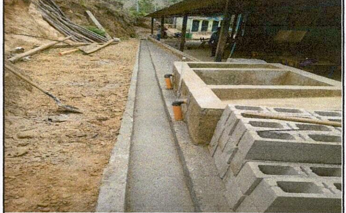
Foto 4: #3. Mejoramiento de Cuneta de concreto.
